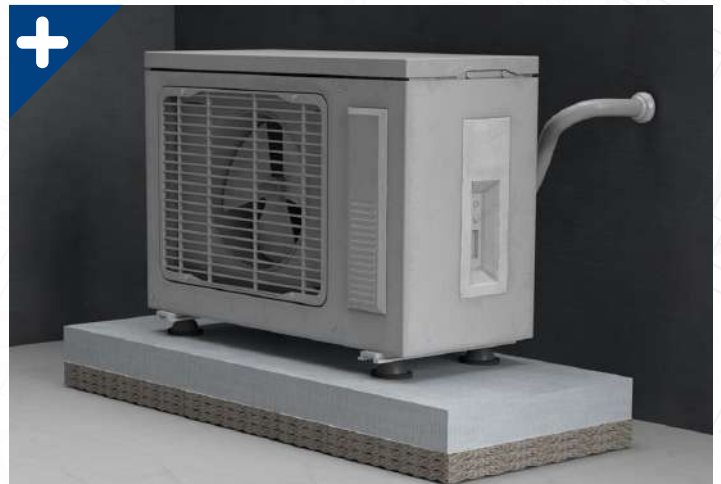
EXEMPLE MACHINE SOUS SOCLE BÉTON
